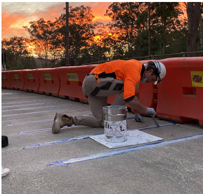
Slot-applied S&P C-Rod (Bending)
