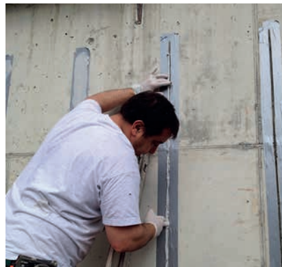
2 Slot-applied S&P C-Laminate (Bending)
